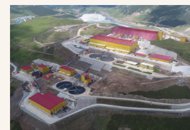
高海拔露天开采矿山——玉龙铜矿
