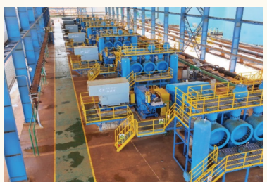
印尼首条红土镍矿浆体长距离管道输送工程——华越镍钴矿浆体管道工程
