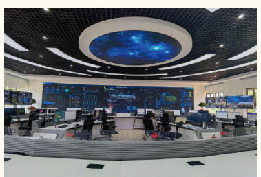
全系统智慧矿山项目——眼前山铁矿智慧矿山（EPC）
