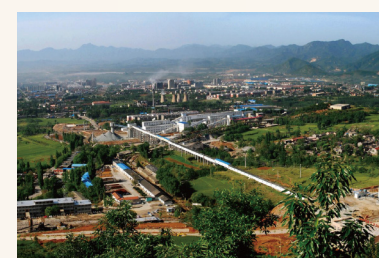
中国第一座自然崩落法矿山——铜矿峪铜矿
